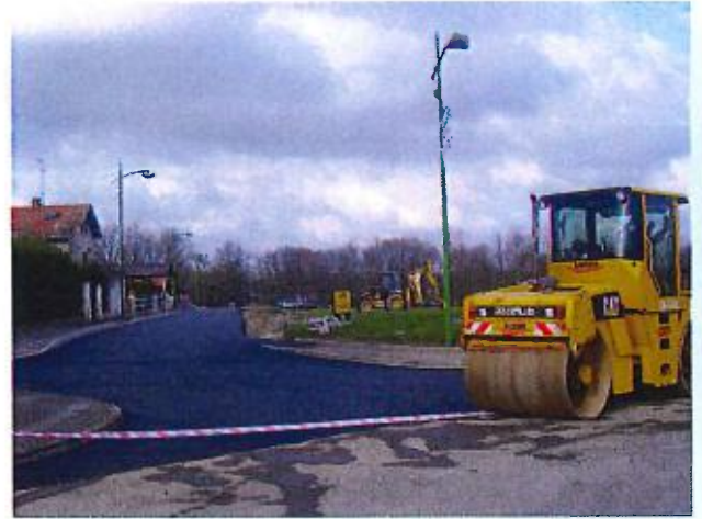
Les travaux de voirie au chemin du Champ de Foire
