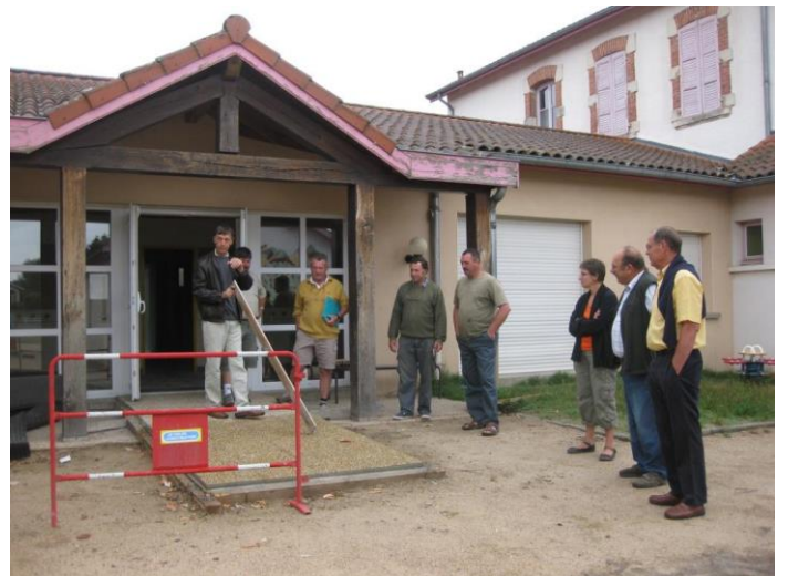
Travaux à l'École : en réunion de chantier
